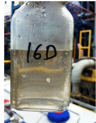
Deoiler Outlet ~50 ppm
